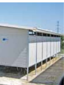
Box svezzamento vitelli rialzato a quattro posti individuali (dim. cm 380×126/155/190)
