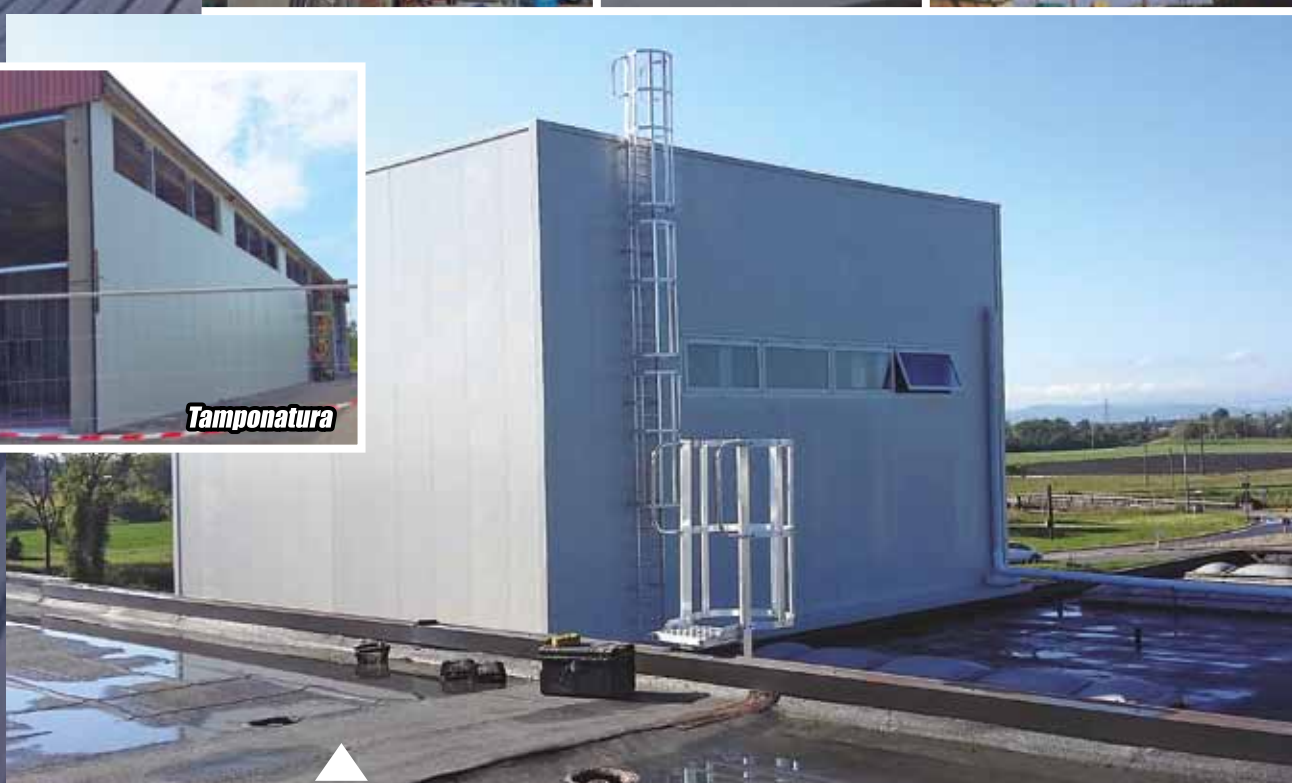
Scala esterna con gabbia di sicurezza
